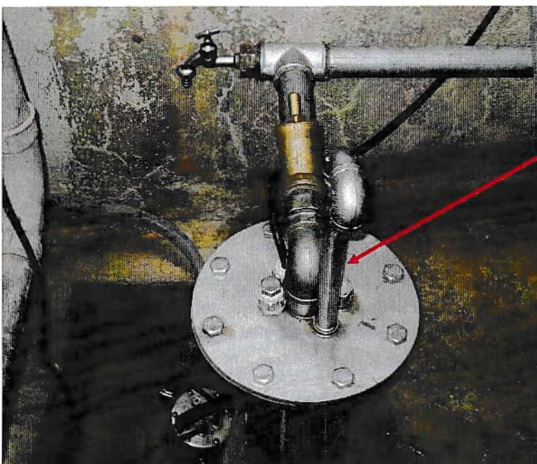
Be- und Entlüftungsrohr
